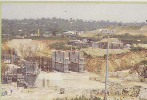
日本の ODA で建設中のソンドミリュウ水力発電所
